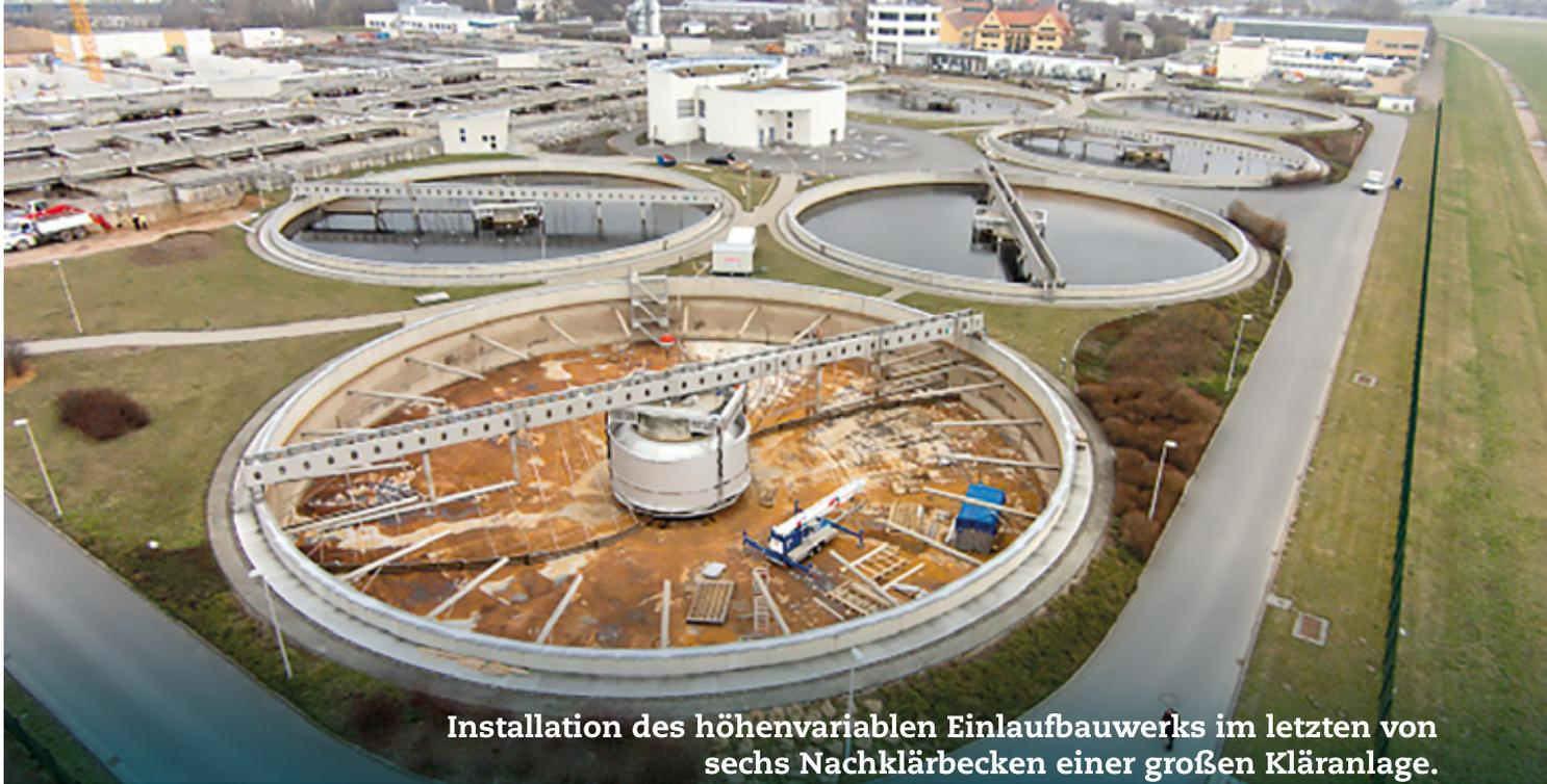
Installation des höhenvariablen Einlaufbauwerks im letzten von sechs Nachklärbecken einer großen Kläranlage.
